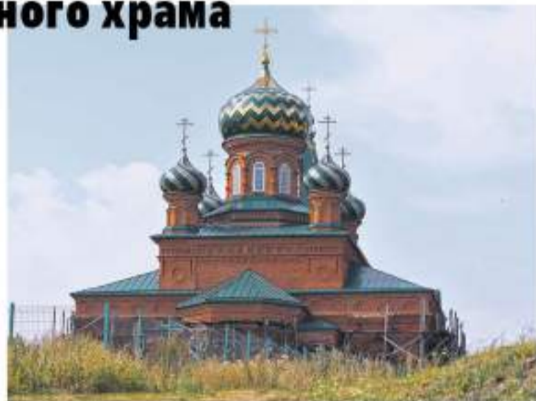
Восстановительные работы ведутся строителями сверху вниз: сначала была отремонтирована зиявшая дырами крыша, затем по кирпичикам восстановлены купола и стены, установлены окна. На сегодняшний день бригада реконструирует колокольню и входную группу
