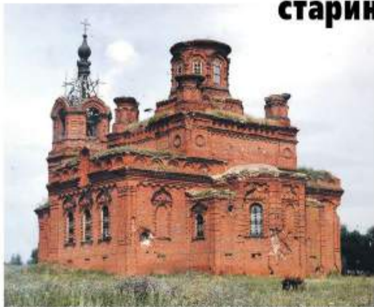
Так выглядел храм в начале реконструкции, к 2004 году на колокольне сохранился лишь накренившийся крест. Прихожане выравнивали его с помощью крана
